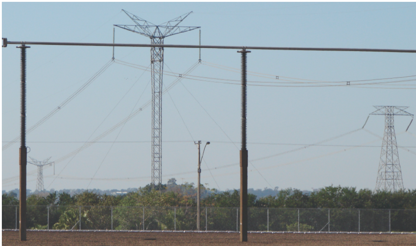
Fig. 18 – Estruturas de linhas de \pm 600 kV do sistema de transmissão de Itaipu, segundo fotografia constante da página 19 do documento R1.
